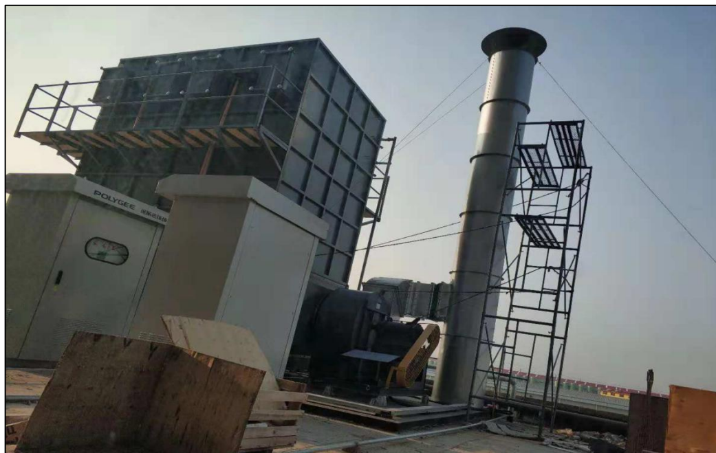
图 4-2 纺丝熔融及纺丝车间油雾废气处理设施
