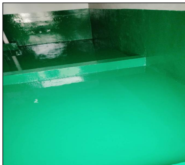
图 4-7.8 危废暂存间防渗地面
